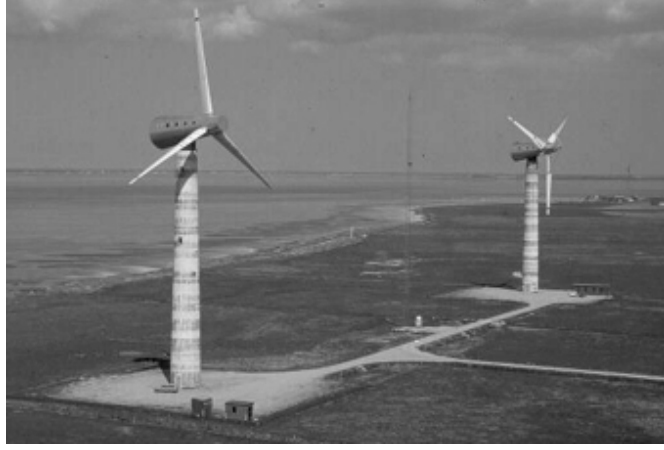
Foto 3: Danimarka'da Nibe yakınlarında, 2X630 kW kurulu gücündeki rüzgar santrali. Türbinlerin, rüzgârların elverişli şartlar sunduğu kıyı kesiminde kurulduğu görülmektedir. ( http://www.afm.dtu.dk/wind/turbines/gallery.htm )
