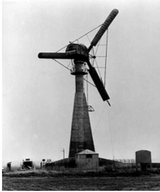
Foto 8: Danimarka'da 1959 yılında faaliyete geçirilen ve ilk modern uygulama olarak kabul edilen Gedser Türbini ( http://www.windpower.dk/pictures/windrush.htm )
