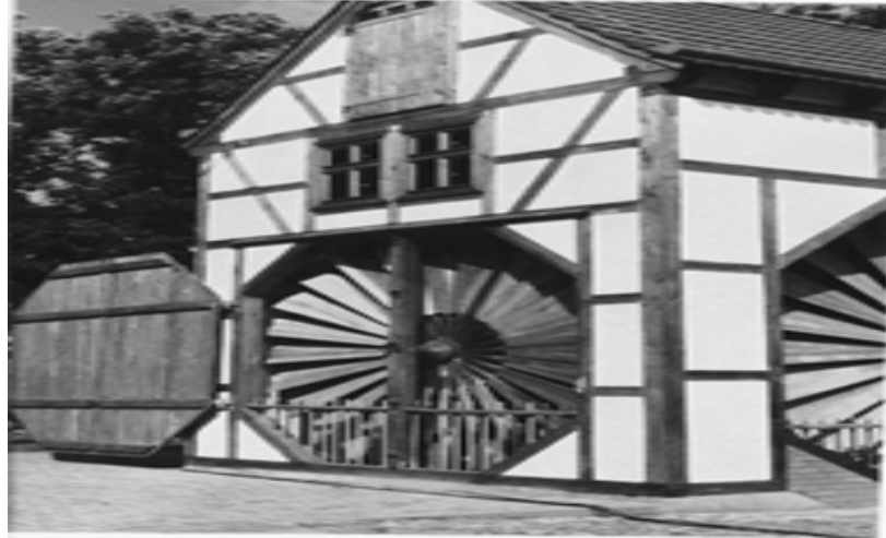
Foto 1: Almanya'da., klasik örneklerinden farklı olarak pervaneleri binanın duvarlarında bulunan bir yel değirmeni. ( http://www.rotor.fb12.tu-berlin.de/picture.rotortypes.html )
