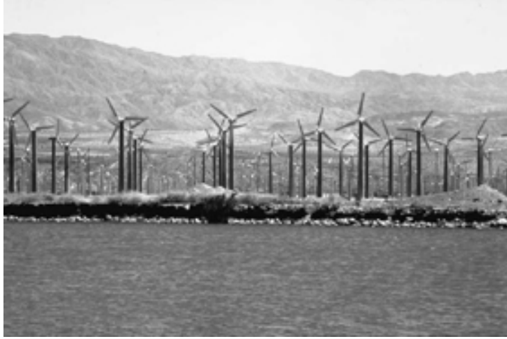
Foto 4: Kıyılarda kurulan rüzgâr çiftlikleri, denizlerden esen sürekli rüzgârların yanında, dağlar ile denizler arasında esen yerel rüzgârlar bakımından da çok elverişli şartlara sahiptir. Fotoğrafta, ABD-California-Palm Springs'de yüzlerce türbinin yer aldığı bir rüzgâr çiftliği görülmektedir. ( http://www.windpower.dk/pictures/windrush.htm )
